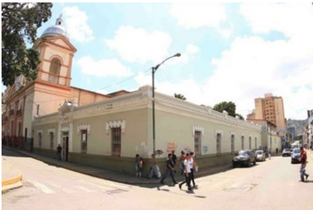
Figura N° 3. Vista actual de la fachada principal de la “Escuela Modelo 19 de Abril”, que fue la primera edificación destinada al uso exclusivo de la actividad educativa en el país
