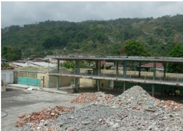
a) Demolición de cerramientos e impermeabilización en losas de techos.
