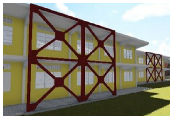
c) Refuerzo sismo resistente de la U.E. "Guillermo Gamarra M."
