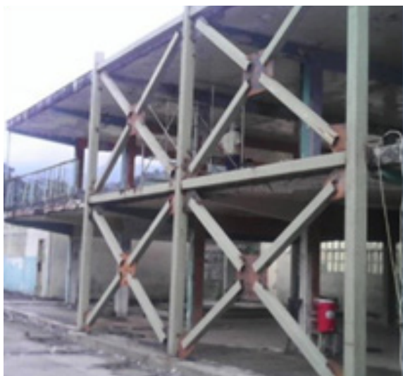
Pórtico externo de refuerzo
