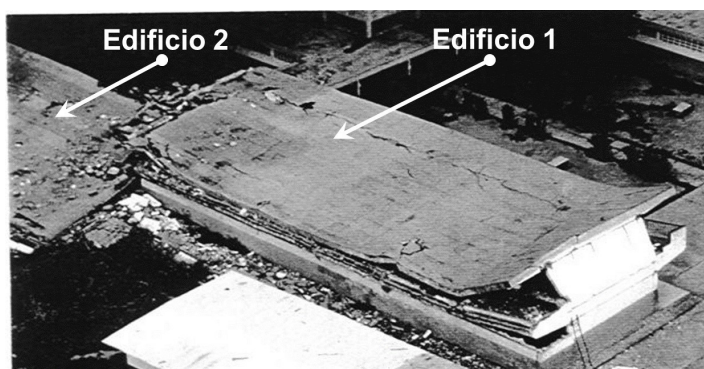
a) Vista aérea de los dos edificios
