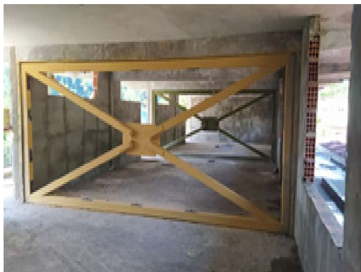
Pórtico interno de refuerzo, en el piso 1.
